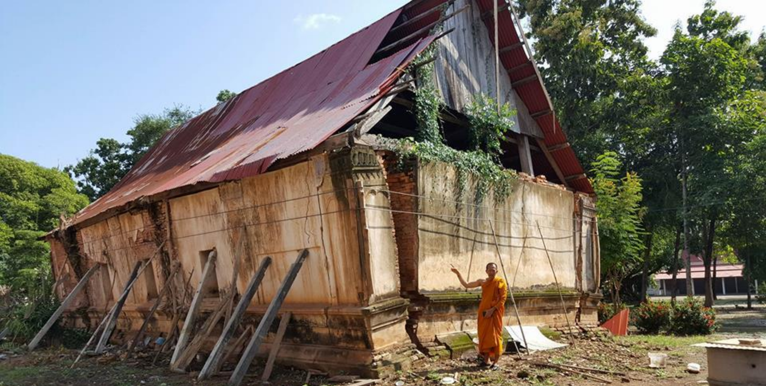
ภาพจาก https://www.tnews.co.th/contents/207885/วอนจิตศรัทธาบูรณะ!!-โบสถ์เก่าวัดอุตรดิตถ์สภาพทรุดโทรมสุดขนาดต้องใช้สลิงตรึงล้อมป้องกันถล่ม-พระสงฆ์องค์เจ้าเตือนร่อนห่างโบราณสถานศิลปะเวียงจันทน์สูญสลาย
